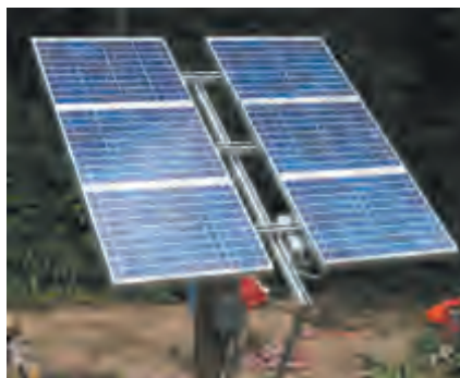
Figura 6. Una aplicación del efecto fotoeléctrico son las celdas solares. Cuando la luz solar incide sobre las placas de metales semiconductores, estos sueltan los electrones de su superficie y adquieren cierta energía cinética que les permite desarrollar una corriente eléctrica que es almacenada en baterías.
